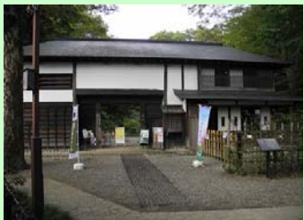
旧本多家住宅長屋門
